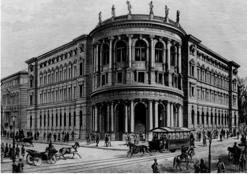
Figura 45. Königliches Museum für Völkerkunde en la Königgrätzer Straße, esquina con Prinz-Albrecht-Straße, Berlín; construido entre 1880-1886.
